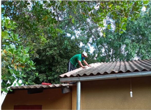
Schoonmaak en voorbereiding voor de eerste verflaag van het dak van het gastenverblijf.
